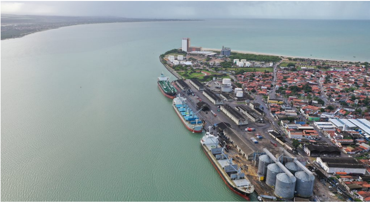
A dragagem será realizada no canal de acesso e na bacia de evolução do porto paraibano, o que ampliará a capacidade de movimentação de cargas em até 57%
